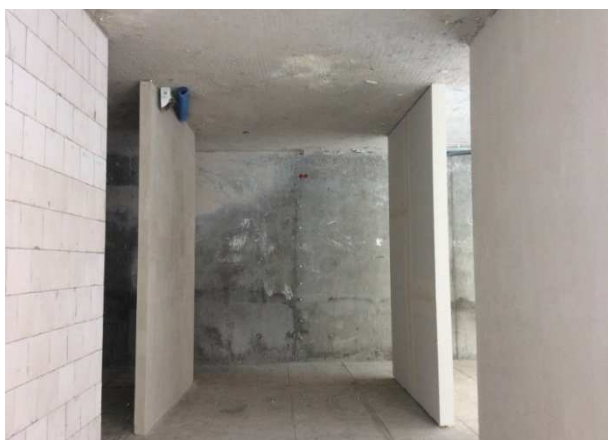
Rys. 9. Widok elementów próbnych ścian działowych (wariantowe rozwiązania zastępcze)
