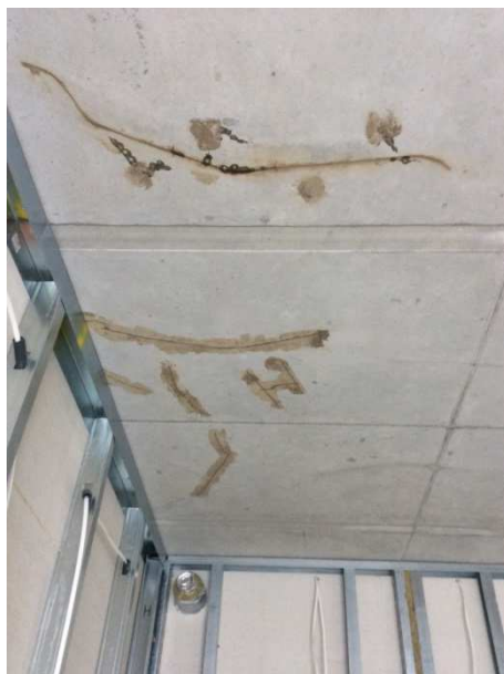
Rys. 10. Widok ścian działowych z płyt g-k na ruszcie aluminiowym zastępujących ściany murowane w budynku
