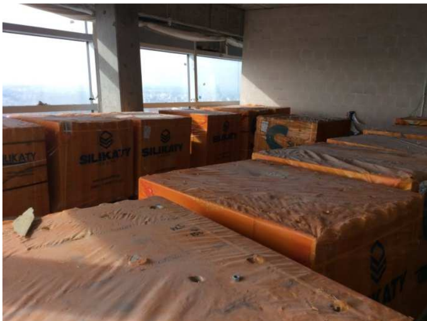
Rys. 4. Widok dociążenia stropu +47 paletami z bloczkami silikatowymi (obciążenie próbne)
